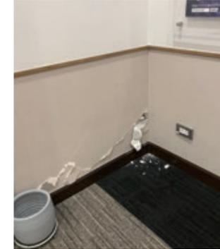
【写真3】地震による弊行オフィスの壁の亀裂
