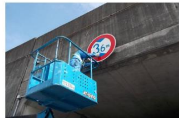
道路標識看板設置
