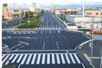
区画線の設置
