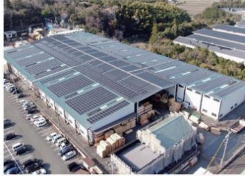
太陽光発電パネルの設置
