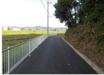
舗装打ち替え工事
