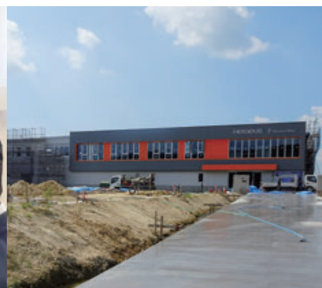
恵那西工業団地で建設中の ヘレウス・エレクトロナイト株式会社 本社社屋
