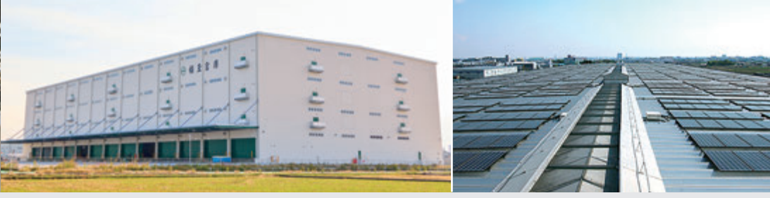
太陽光システムを屋上に設置するなど、環境負荷の低減をはかる
