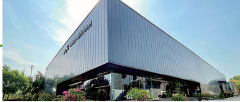
ベトナム工場外観
