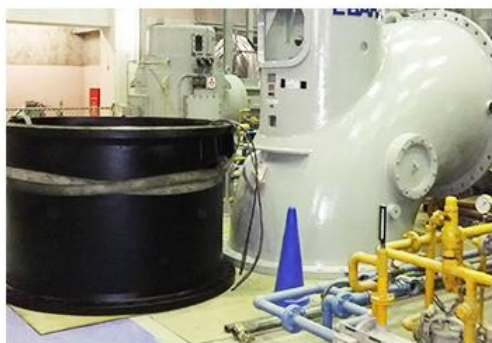
上下水道給排水ポンプ設備や水処理設備の据付、配管、電気工事
