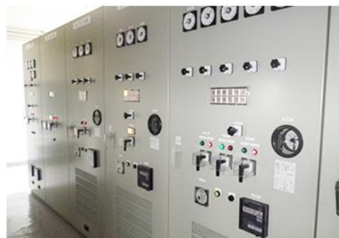
自家発電機設備の据付、配管、電気工事
