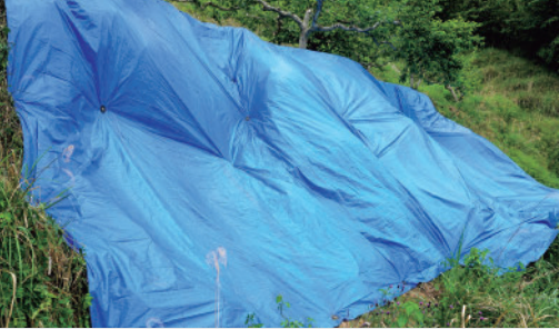
ワイヤーアンカーの施工事例
